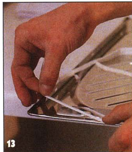
13 Теперь можно встраивать новую мойку. Сначала к желобкам по краям тыльной стороны раковины приклеивают уплотнительную ленту.
