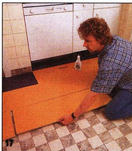
17 Нанеся клей на шип укладываемой плиты, её пристыковывают к уложенной, слегка подбивая молотком через деревянную подкладку.
