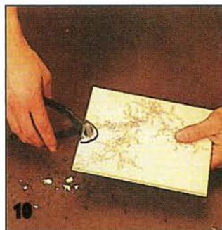
10 Полукруглые выемки на краях плиток выламывают специальными клещами.
