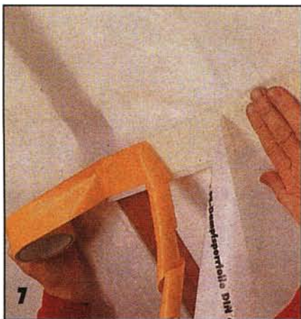
7 Отдельные полотна плёнки укладывают с напуском друг на друга и склеивают самоклеящейся лентой.
