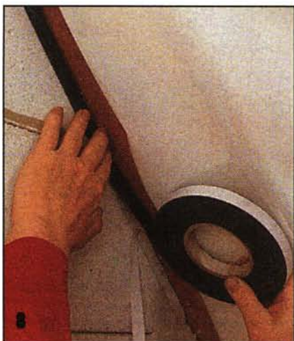
8 Места примыкания плёнки к фронту и другим элементам, прерывающим ветрозащитный слой, заделывают специальной уплотнительной лентой. На фото её приклеивают в зоне фронтовой стены.
