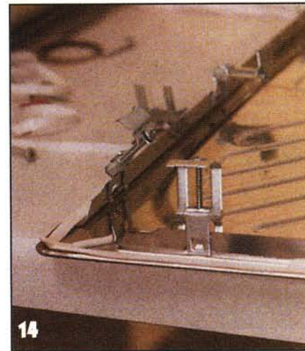
14 Затем надевают крепёжные накладки, удерживающие снизу на кухонной рабочей плите раковину мойки.
