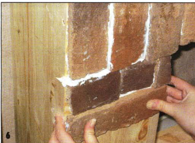
6 Облицовку каменной плиткой вели по заранее продуманной схеме. Причём при раскрое плитку просто ломали, не заботясь о ровности кромок в местах разломов.
