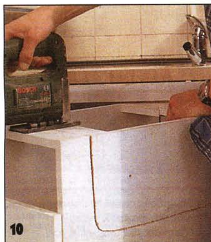
10 Чтобы можно было установить ещё и маленькую раковину, из тумбы удаляют выдвижной ящик и делают в ней вырез соответствующих размеров.
