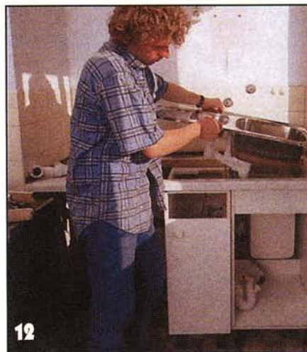
12 Прежде чем установить раковину мойки, ещё раз проверяют, подходит ли она в вырез кухонной рабочей плиты и в проёмы тумбы.
