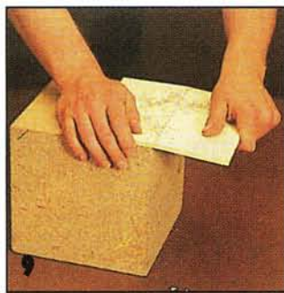
9 Но можно обойтись и обычным стеклорезом. Надрезав глазурь, плитку ломают о ровный край удобного для этого предмета.
