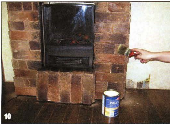
10 В завершение облицовку покрыли защитным слоем водостойкого лака.
