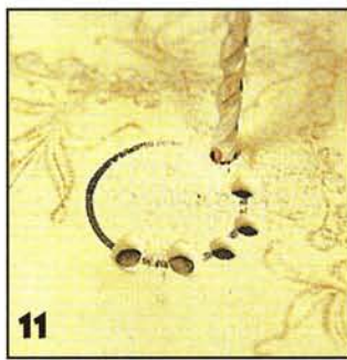
11 Если нет кругореза для керамической плитки, отверстие в середине плитки проделывают вот так. Сначала сверлом по камню сверлят по окружности несколько отверстий.
