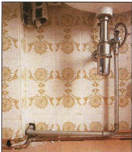
6 Из ванной через стену сюда прокладывают новый трубопровод холодного водоснабжения, предварительно расширив отверстие в стене.
