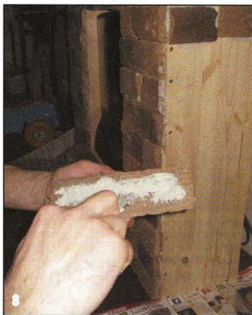
При облицовке клей наносили на тыльную сторону плитки с избытком так, чтобы часть его выдавливалась в швы.
