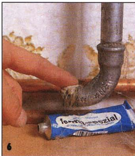
6 Затем паклю обмазывают специальной пастой, наносимой пальцем по кругу в направлении витков обмотки.
