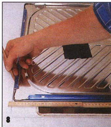
8 Разобрав тумбы, определяют положение проёма для встраивания новой мойки. Для этого мойку кладут дном вверх и по её краям размечают контуры отверстия на рабочей столешнице.
